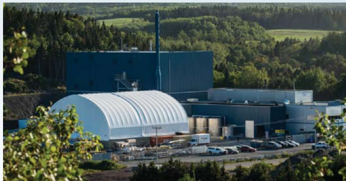
La nouvelle usine en construction, Cap-Chat, Gaspésie
